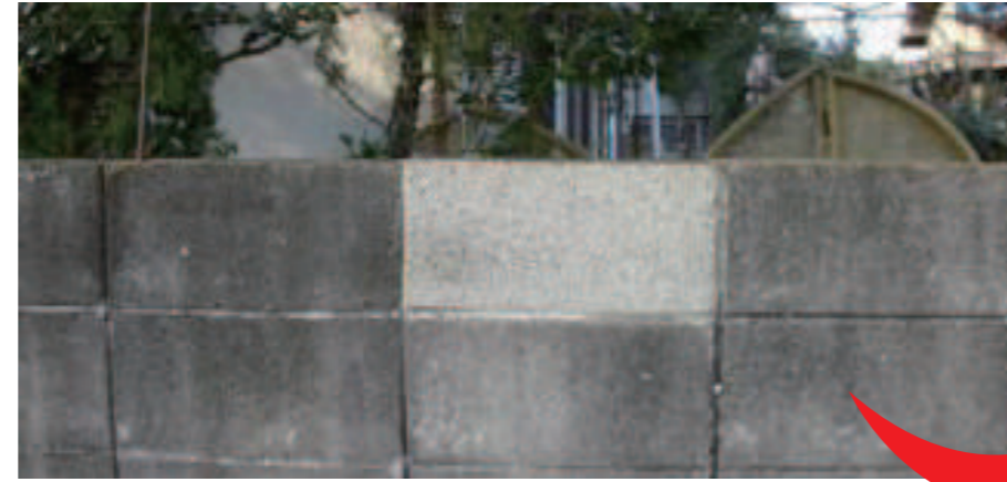
クオクリア施工直後 2007年1月
