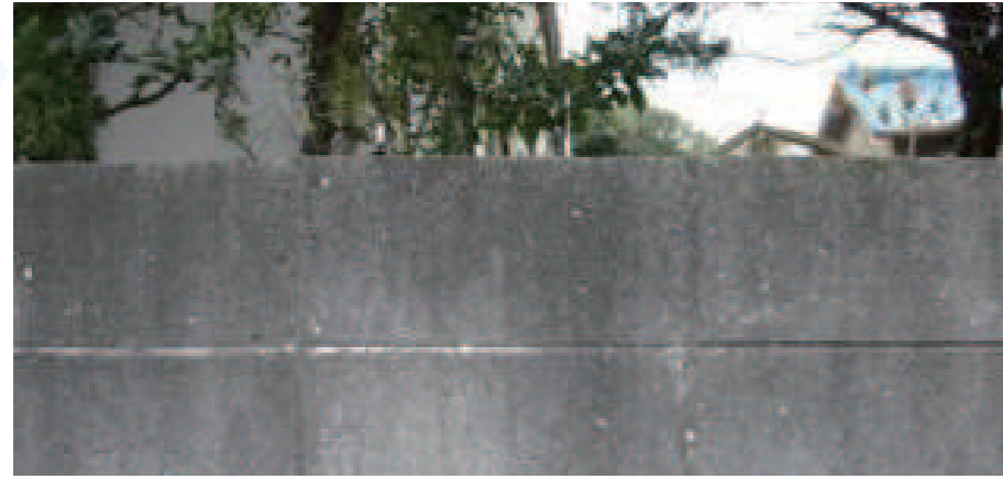
初期状態 施工前に洗浄し クオクリアを施工
